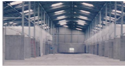
発酵処理施設内部
